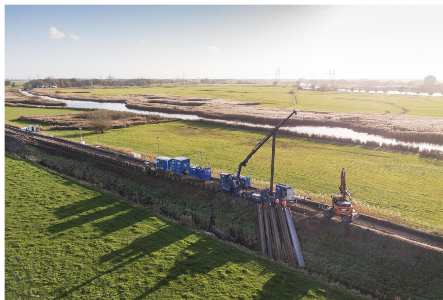
Stenendijk Hasselt, eerste emissieloze dijkversterking
