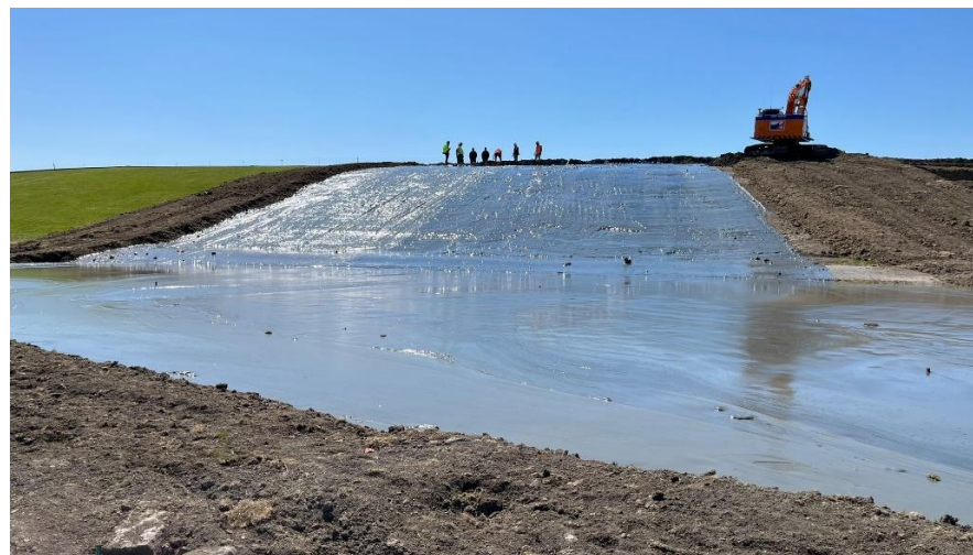
Pilot de Rijpdijk met slib uit de Eems-Dollard
